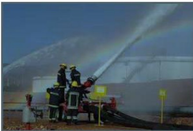
FIGURA 5 - Esempi di monitor antincendio e di rete antincendio di raffineria
