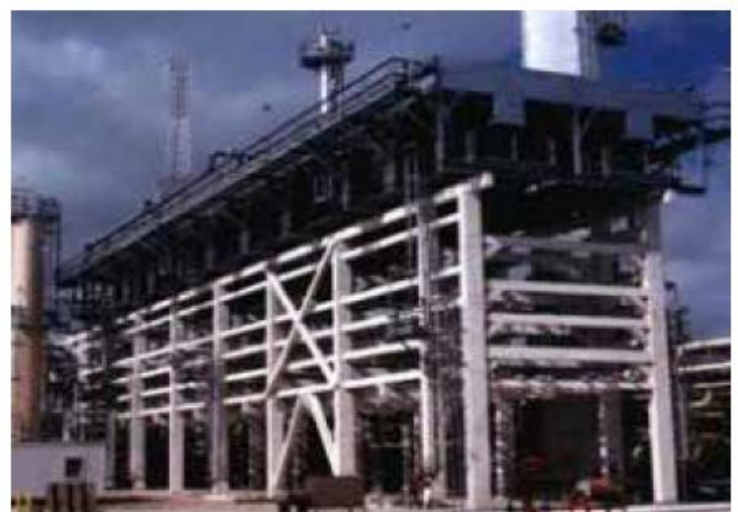
FIGURA 4 - Esempio rivestimento antifluoco di strutture portanti
